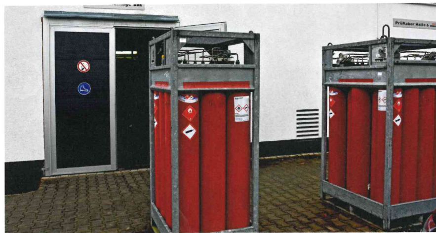
Bild 1: Ansicht Zugang Gasmischanlage und Prüflabor GWI: Der Blick vor dem Zugang in die beiden Bereiche Gasmischanlage mit den Reingas- und Mischgas-Behältern links sowie zum Prüflabor rechts
